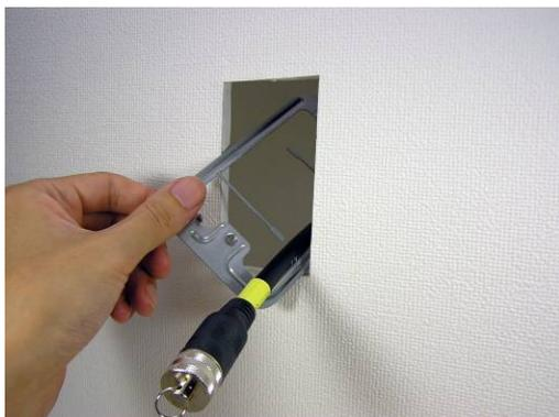
3. A および B 部を壁の外へ引き出し、壁に沿って折り曲げはさみ金具を仮止めします(下記写真参照)。
