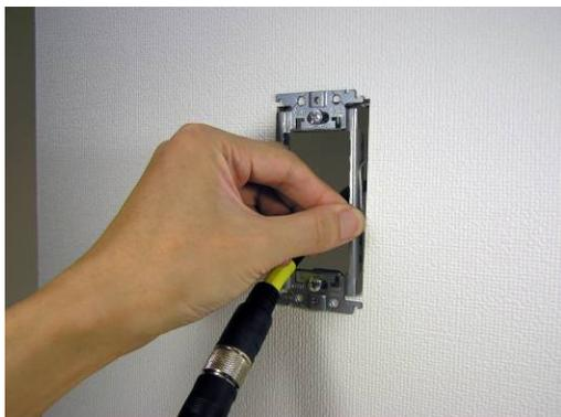
8. AVコンセント付属の白いフェイスプレート用ネジを使い、フェイスプレートを取り付けて完成です。
