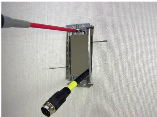
6. 専用中継ケーブルを、AV コンセントと接続します。
