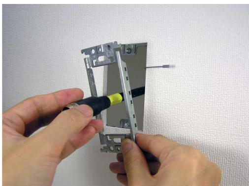
5. 付属のネジ 2 本を使い、壁を挟んではさみ金具と壁面取付金具をネジ止めします。
