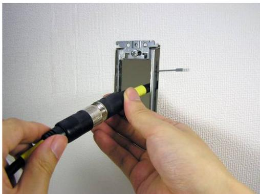
丸型 DIN コネクタタイプの中継ケーブルを使用している場合は、ネジ止めリングをしっかりと締めます(下記写真参照)。
